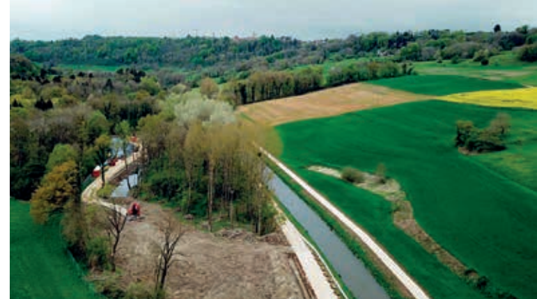
Vue aérienne des travaux d'élargissement en rive gauche de la Venoge vers Lussery-Villars. – Photo Raphaël Mahaim
