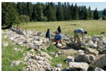
Construction d'un mur en pierres sèches – Antoine Burri
