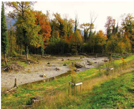
Plantation d'une végétation diversifiée au pied de la nouvelle digue. - Photo François Sugnaux
